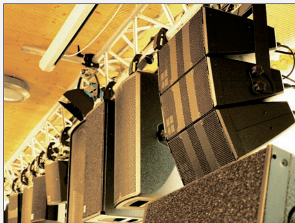
Obr. č. 4: Na trussingu pod stropem jsou zavěšeny všechny menší typy reprosoustav včetně malých line-array systémů série T.
