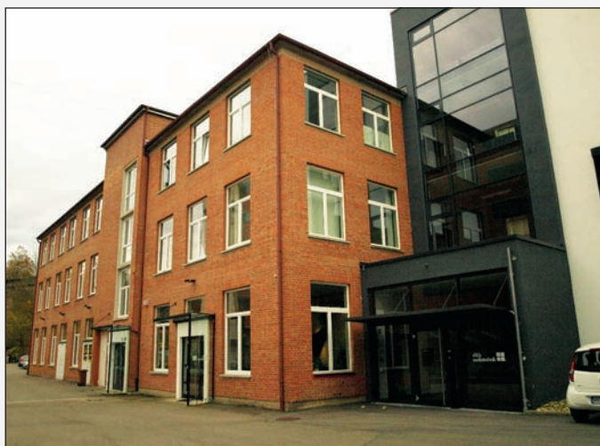
Obr. č. 1: Sídlo d&b audiotechnik tvoří část nádherného, architektonicky cenného komplexu památkově chráněných objektů bývalé textilky v městečku Backnang nedaleko Stuttgartu.
